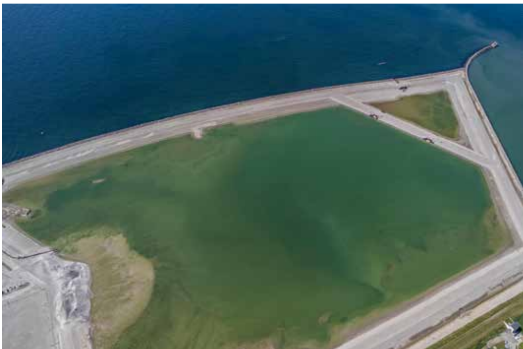
Luftfoto af Femern Link Contractors byggeplads, Rødbyhavn, Lolland Foto: Kenneth Bagge Jørgensen/Colourbox
